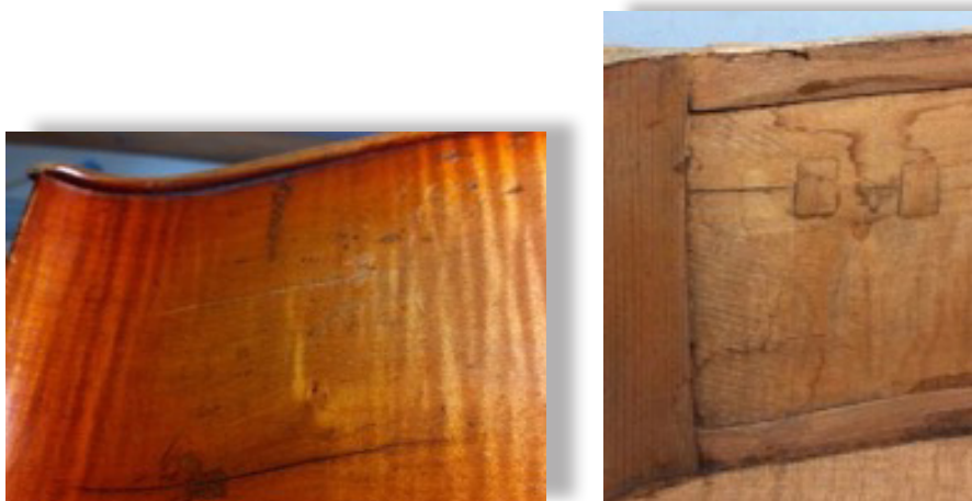
Ilustración 3. Grietas en el aro de un violonchelo producidas por los cambios climáticos. El taco en el interior del instrumento bloquea la movilidad natural de la madera en la zona donde ambos están encolados.
