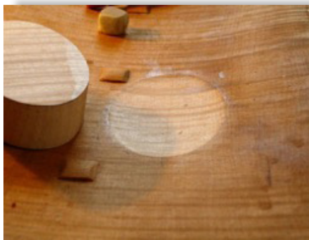
Ilustración 25. Parche o pieza de alma a “media madera”.
